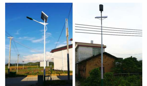
改造新建太阳能路灯
